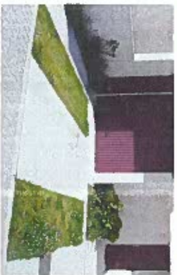
Bande de roulement béton
